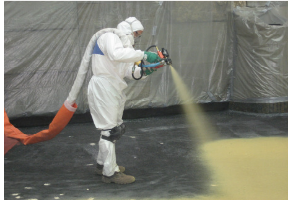
Das Material Polyurea härtet ungewöhnlich schnell aus und haftet optimal auf Beton und Stahl, Kunststoffen, Glass und Keramik. | Foto: VIP
