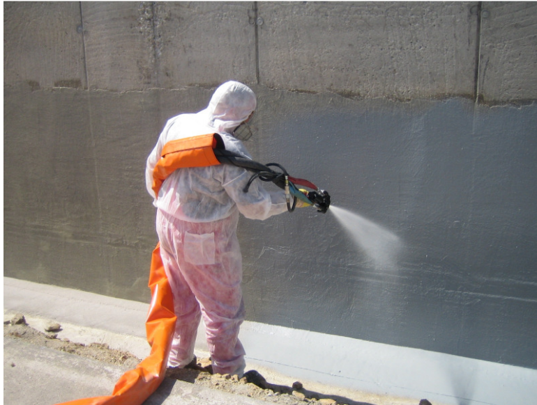
Vom Industrieboden bis zum Betonsockel: Mit Polyurea lassen sich Oberflächen schneller beschichten. | Foto: VIP
